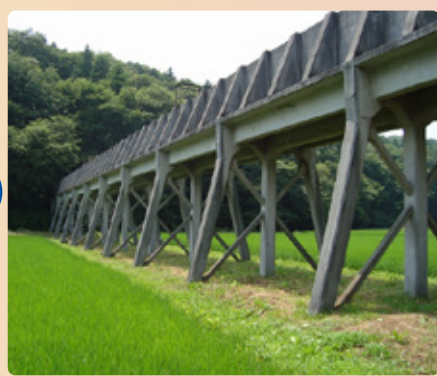
ぜんだなすいろうきよう 膳棚水路橋 (土木遺産)
